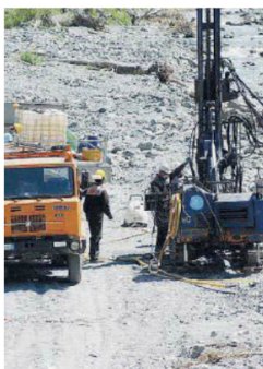
Nell'alveo del torrente Oliva I carotaggi nel corso d'acqua
