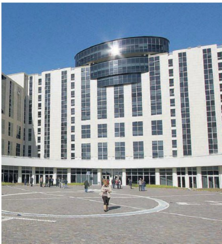
Inadempienti La Cittadella ha nominato 17 commissari ad acta negli enti morosi
